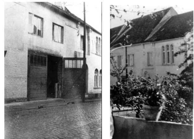
Synagogenansicht von Norden/ Südstraße. Die Fotos stammen aus der Zeit nach der Renovierung (rechtes Bild 1956). Der Turm ist nicht mehr zu sehen.
