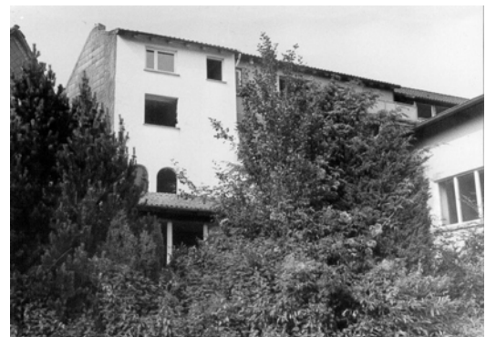
Verschiedene Ansichten des Synagogengebäudes nach Renovierung und Umbauten. Man erkennt noch deutlich die z.T. zugemauerten ursprünglichen Fenstererelemente. Der kleine Turm wurde im Zuge der Dachsanierung ebenfalls entfernt.
